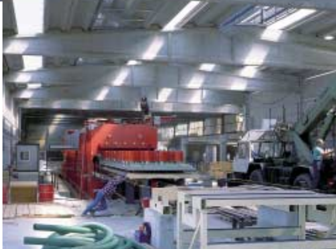
1. Copertura con tegoli Neoplan distanziati da lucernari zenitali a filo falda.
