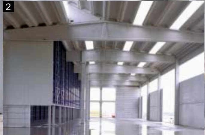
1. Copertura con tegoli Neoplan distanziati da lucernari zenitali a filo falda.
